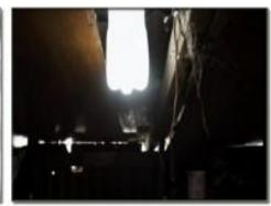
屋頂控洞,塗上密封劑, 把卡住金屬片的塑膠瓶 放入屋頂控好的洞裡
