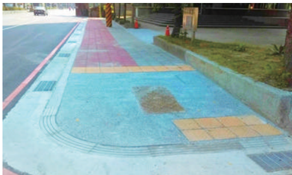
行人通行空間改善後 (增加人行道及自行車道)
