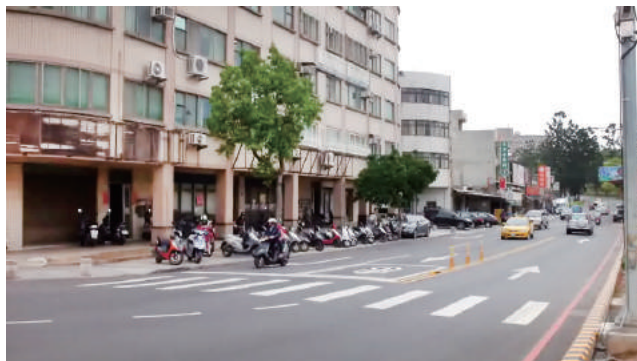
環島西路一段浯江北堤路口拓寬、增設右轉車道
